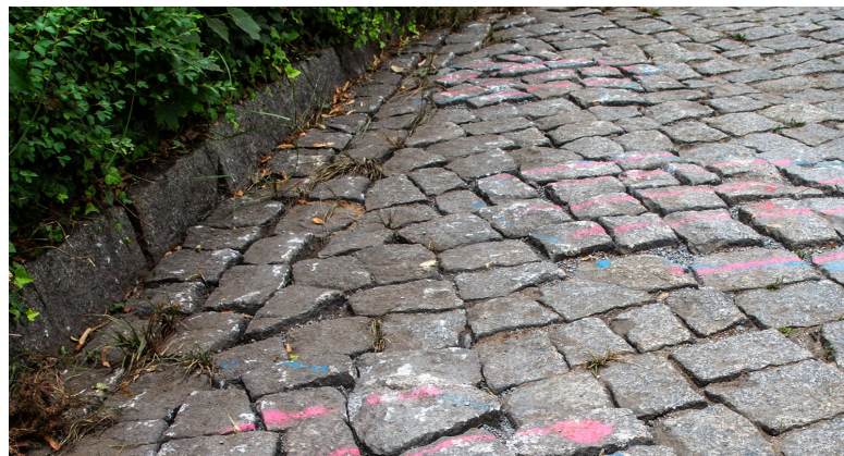
Anheben der Pflasterflächen
